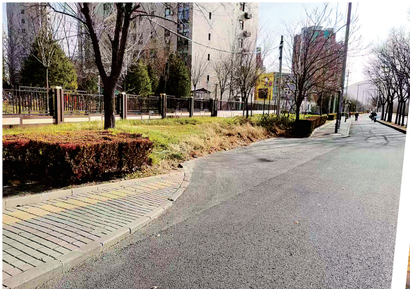
温泉路改造前
